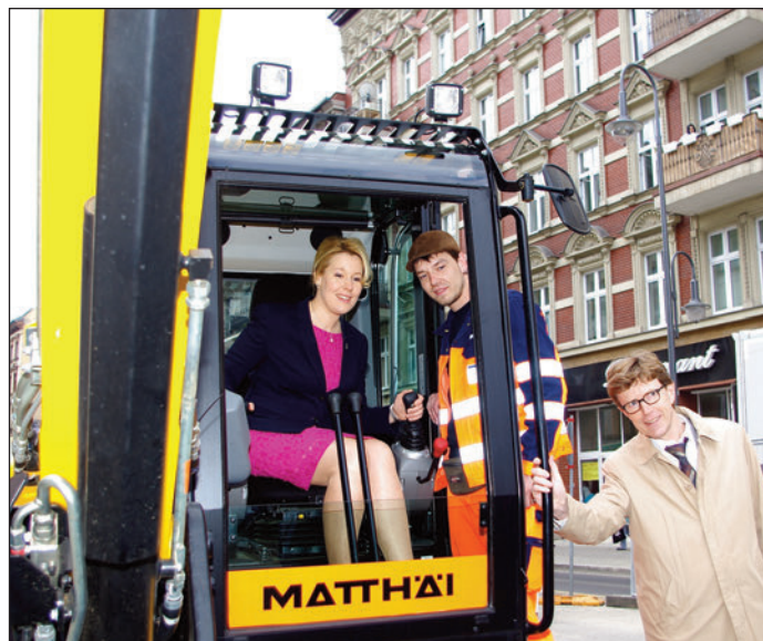
Der Umbau der Karl-Marx-Straße gleicht einer Operation am offenen Herzen“, sagte Giffey treffend, hier im Bagger sitzend. Es galt Schäden am U-Bahntunnel zu vermeiden.
